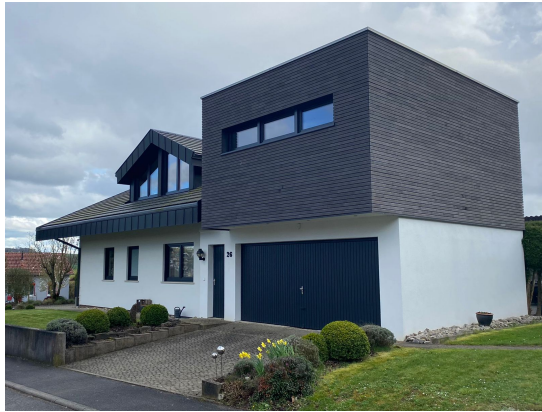
ANBAU UND AUFSTOCKUNG HAUS K.
