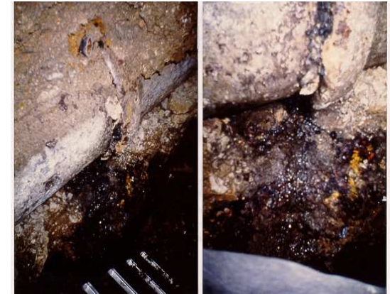
Defekter Abwasserkanal Metallverarbeitung!
