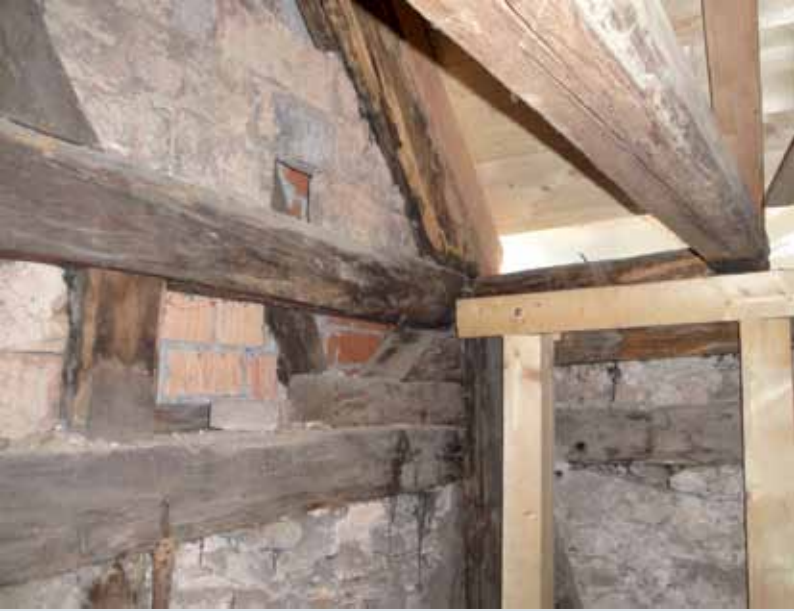
Dachkonstruktion einer Remise mit Ergänzungen in Weinstadt-Strümpfelbach
