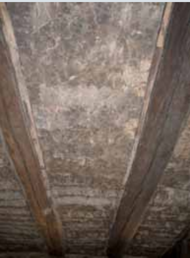
Lehmwickeldecke eines Wengerterhauses in Strümpfelbach
