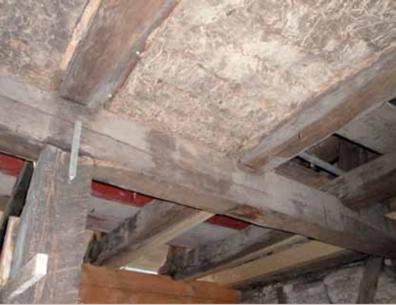
Holzkonstruktion mit Lehmwickeldecke
