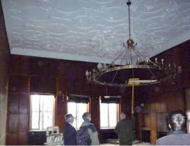
Denkmalrelevante Stuckdecke eines ehemaligen Offizierskasinos in Ludwigsburg
