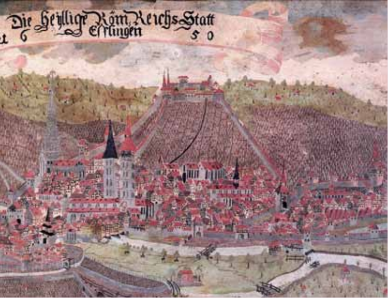
Besonders brandgefährdete Mühlen vor den Toren der Stadt; Stadtansicht Esslingens um 1650 aus „Stadt-Findung“, LDA et al. (Hrsg.)
