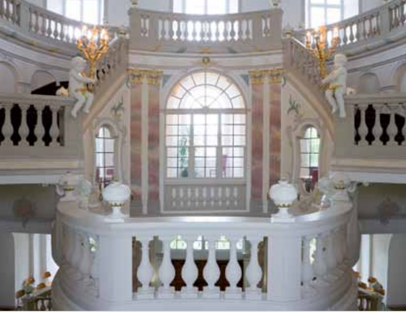
Repräsentative Schosstreppe Schloss Bad Wurzach – Brandschutzmängel können ggf. durch Brandlastfreiheit kompensiert werden (Foto Stiftung Schloss Bad Wurzach)
