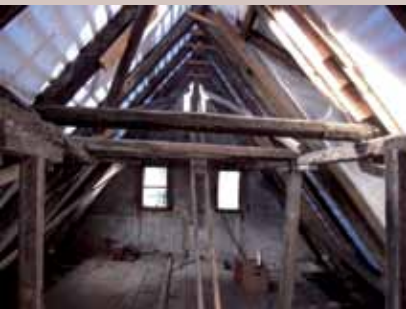
Unausgebauter Dachraum (Foto Stemshorn Architekten)
